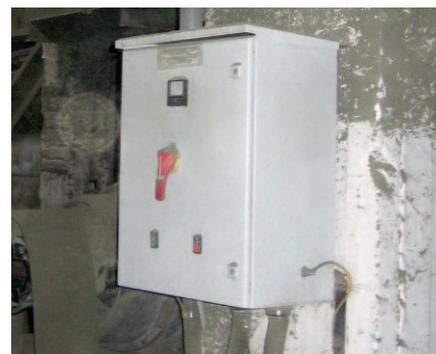
Рис. 9. Местный выключатель безопасности
